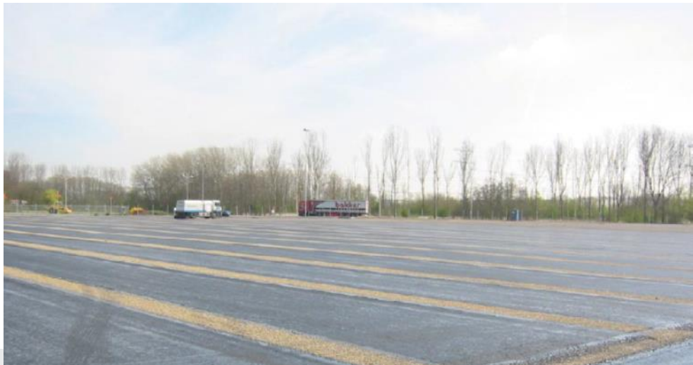
Foto: Aanleg vloeistofdichte asfaltconstructie (bron: VBW Handleiding vloeistofdichte bitumineuze constructies).
